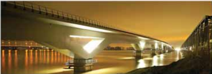
HSL Bridge, Moerdijk/Netherlands
